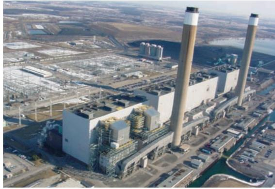
**La centrale de Nanticoke d'OPG (3 938 MW)** sur la rive nord du Lac Érié. Le matériel de réduction catalytique sélective (qu'on aperçoit à l'avant-plan) récemment installé sur deux des huit unités de production de la centrale a aidé Nanticoke à atteindre en 2004 son plus faible taux d'émissions d'oxyde d'azote jamais enregistré et les plus faibles émissions totales d'oxyde d'azote depuis l'entrée en service de la centrale en 1978.
