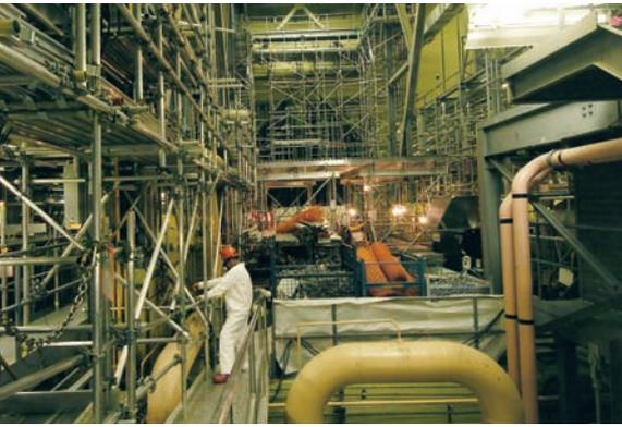
**L'échafaudage est en place pour les ouvriers** dans le bâtiment réacteur de l'unité 1 de la centrale Pickering A. Cet échafaudage compte plus de six kilomètres d'échelles. Les travaux de remise en service de l'unité 1 nécessiteront l'intervention de plus de 2 800 employés d'OPG et de contractuels, qui exécuteront plus de 20 000 tâches de construction nécessitant près de trois millions de pièces.
